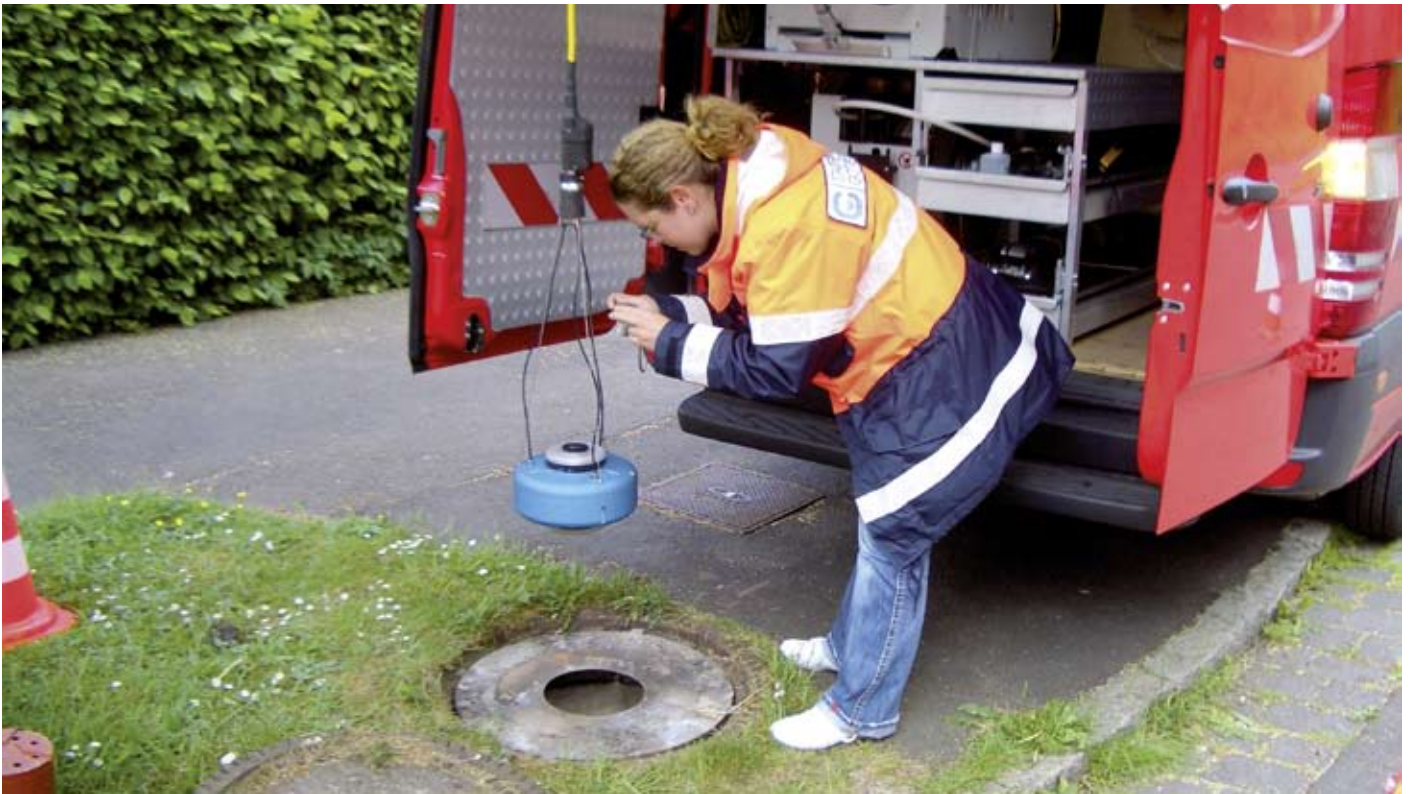
Maschinelle und manuelle digitale Schachtaufnahme.
