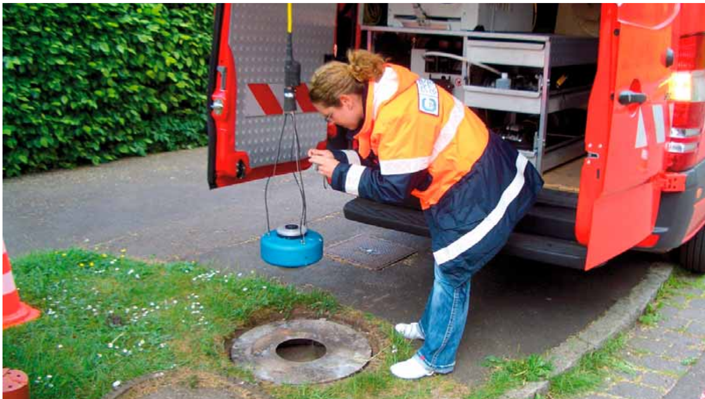
Maschinelle und manuelle digitale Schachtaufnahme.
