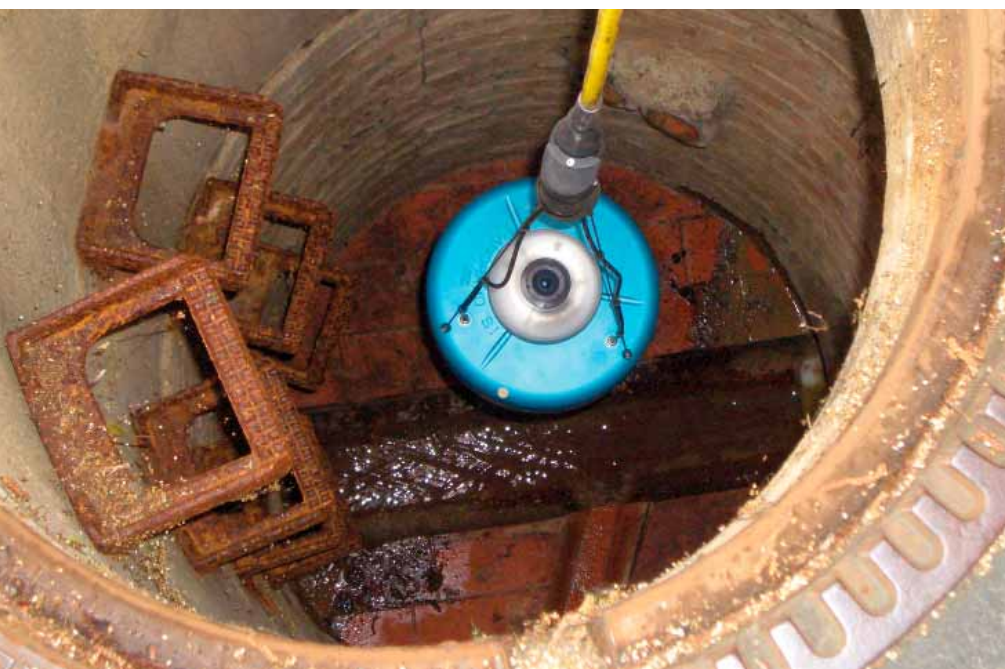
Panorama SI während der Befahrung
