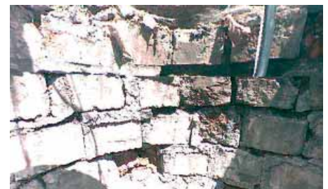
Mauerwerk unterhalb Konus
