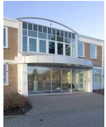
IBAK Werk-Kiel Haupteingang
