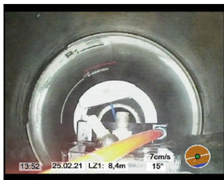
Unter Beobachtung über die Farbschwenkkopfkamera CutterCam wurde der Packer mit Manschette exakt an den jeweils abzudichtenden Bereichen positioniert.
