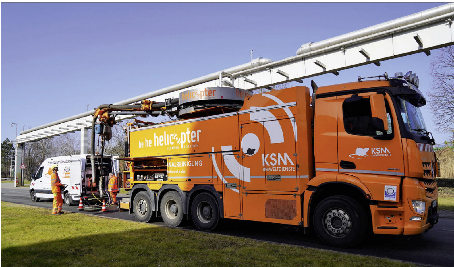
Eingespielte KSM-Teams: Die Saniertruppe mit dem MicroGator im Sprinter folgt unmittelbar nachdem der Hochdruckspüler die Reinigungsarbeiten abgeschlossen hat.
