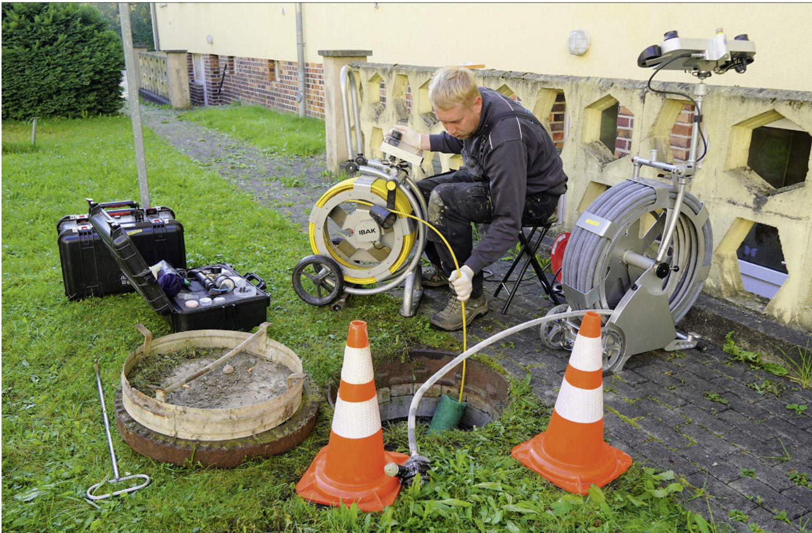
Mit der Schiebekamera-Anlage MiniLite verschaffte sich Aqendo-Mitarbeiter Steffen Mies zunächst einen Überblick über die Leitung, bevor er mit dem Hausanschlussfräser NanoGator die durch das Einbringen des Schlauchliners verschlossenen Zuläufe wieder öffnete.
