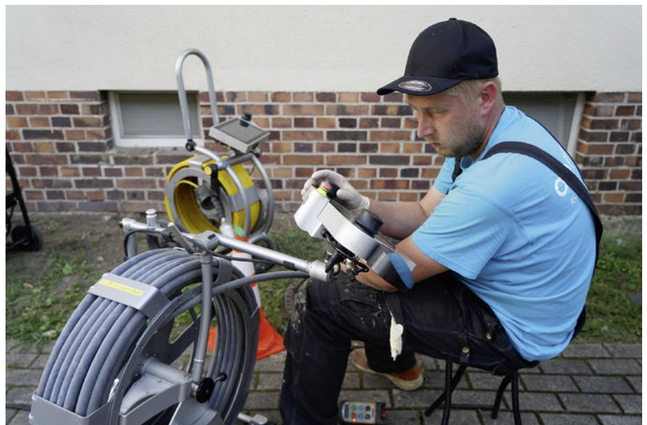
Aqendo-Mitarbeiter Steffen Mies ordnete sich die Haspel und das Bedienpult des NanoGators flexibel an die jeweiligen Gegebenheiten ergonomisch sinnvoll an. | Fotos: IBAK
