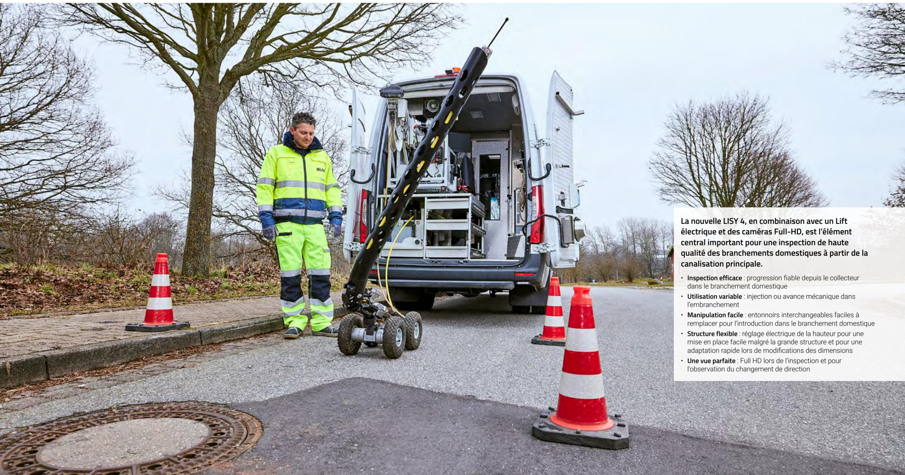
La nouvelle LISY 4, en combinaison avec un Lift électrique et des caméras Full-HD, est l'élément central important pour une inspection de haute qualité des branchements domestiques à partir de la canalisation principale.
