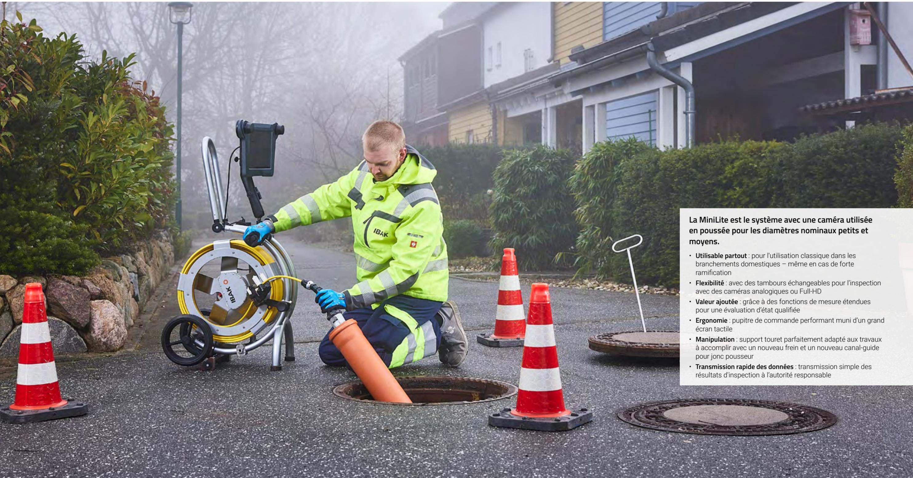
La MiniLite est le système avec une caméra utilisée en poussée pour les diamètres nominaux petits et moyens.
