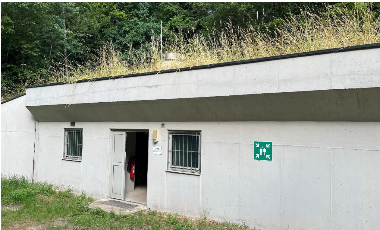
Bildunterschrift (IMG_0407.jpg): Eingang zum Kontrollstollen.
