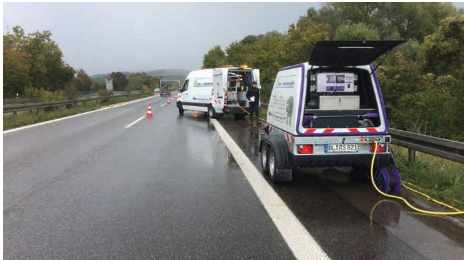
Die Firma RS Kanal- und Umweltservice GmbH aus Balingen ist Vorreiter in der Anwendung der Falch-Höchstdruck-Wasserstrahltechnik am MicroGator-Geräteträger. Seit über einem Jahr bewährt sich das Verfahren im Kanal. | Foto: Falch
